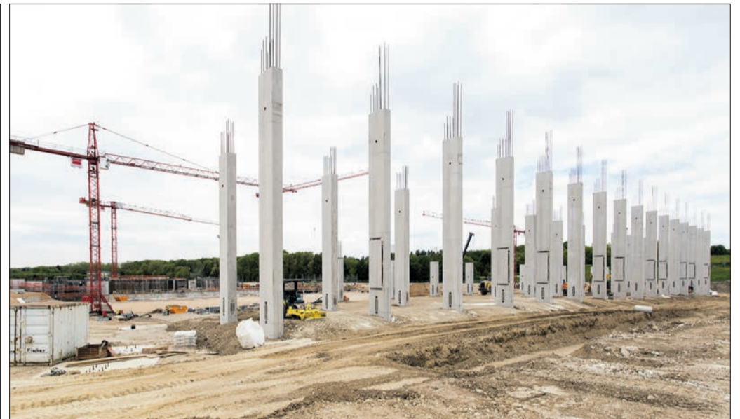
Erste Konturen sind bereits erkennbar: Das neue Stadion am Flugplatz wächst rasch, und ein Baustopp ist juristisch abgewendet. (Foto: A. J. Schmidt)
