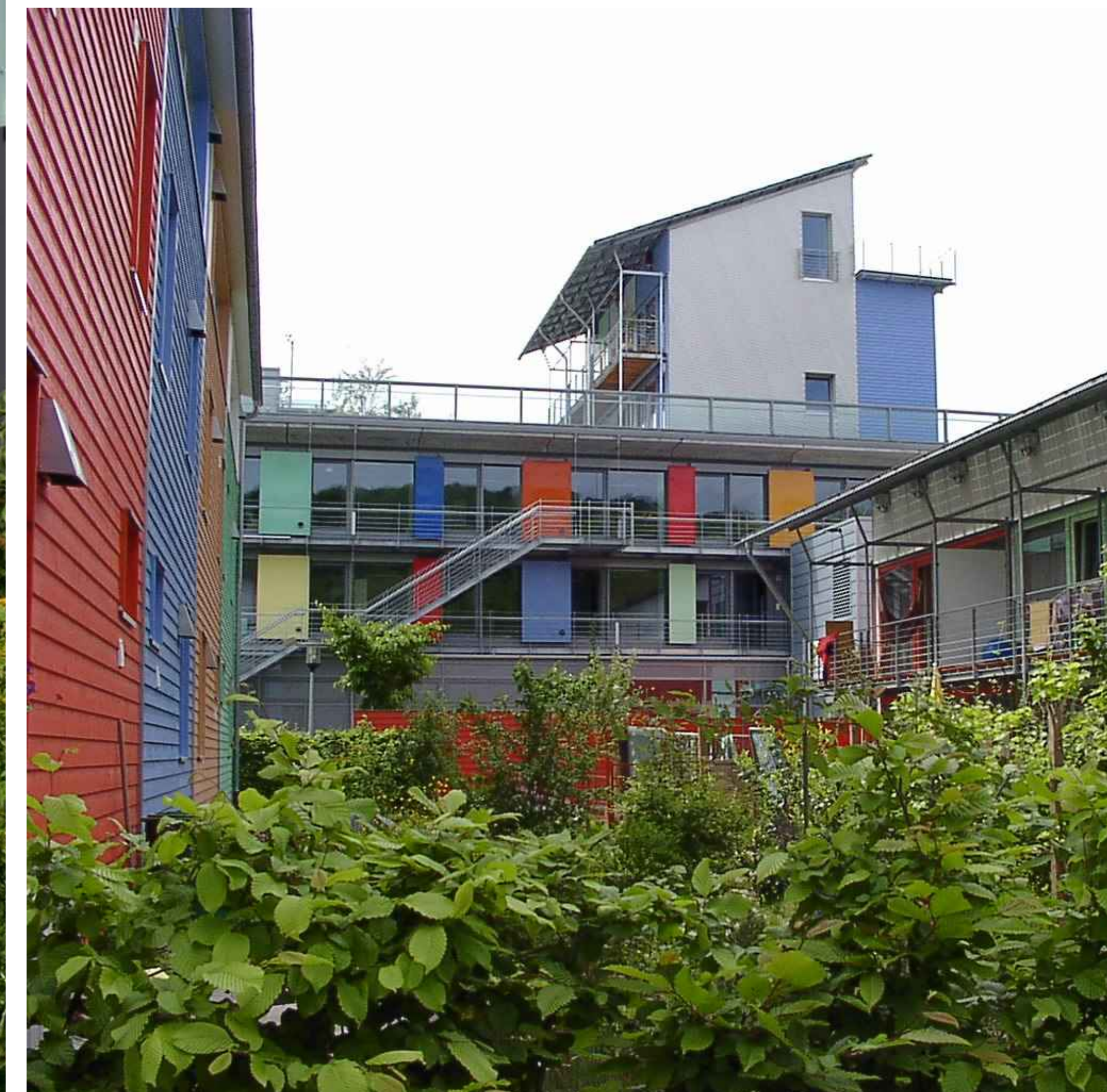
Gewerbl. Bauträgerproj. "Solarsiedlung" - The "Solar Village", a project by commercial property developers
