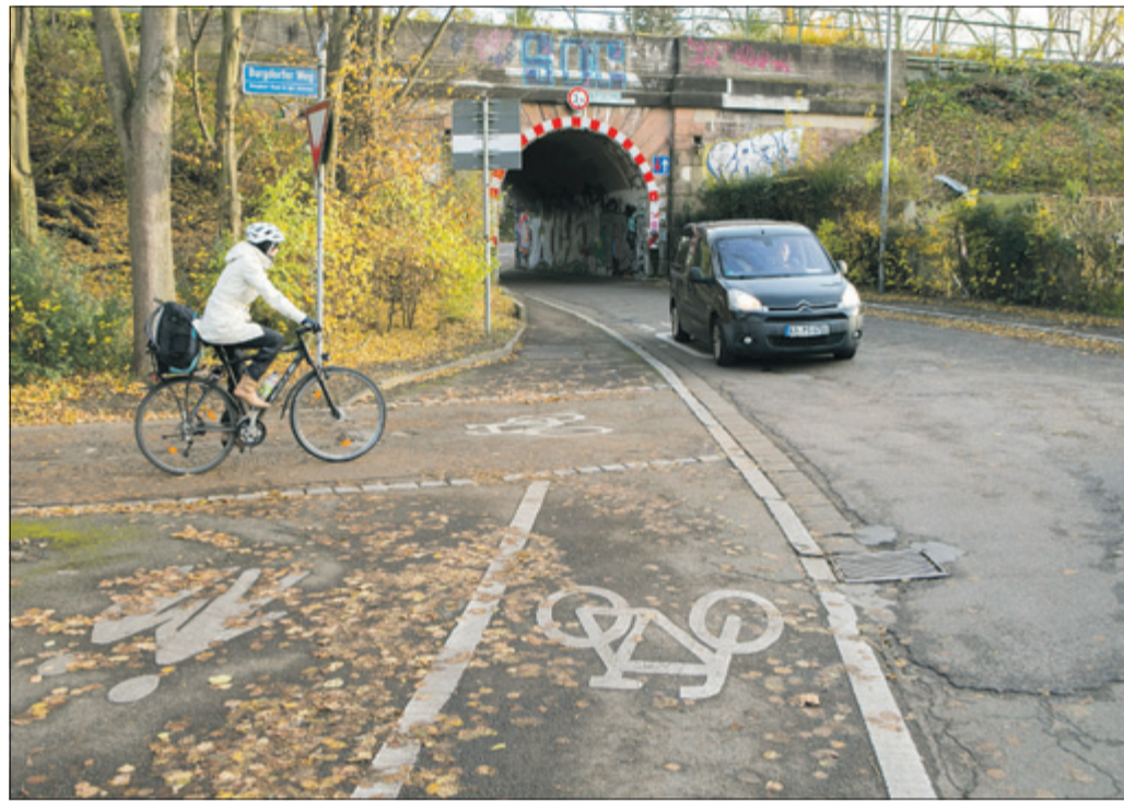
Nadelöh: Die Bahnunterführung in der Hinterkirchstraße wird von vielen Fußgängern, Radlern und auch Autos genutzt. Manche Anwohner wünschen sich eine Sperrung für den Autoverkehr. (Foto: A. J. Schmidt)
