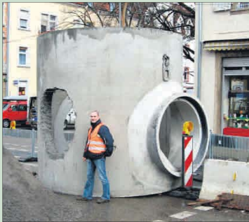
Überall in der Stadt müssen nach und nach alte Abwasserrohre gegen neue ausgetauscht werden. Wie hier in der Eschholzstraße jetzt auch in der Habsburgerstraße. (Foto: Badenova)
