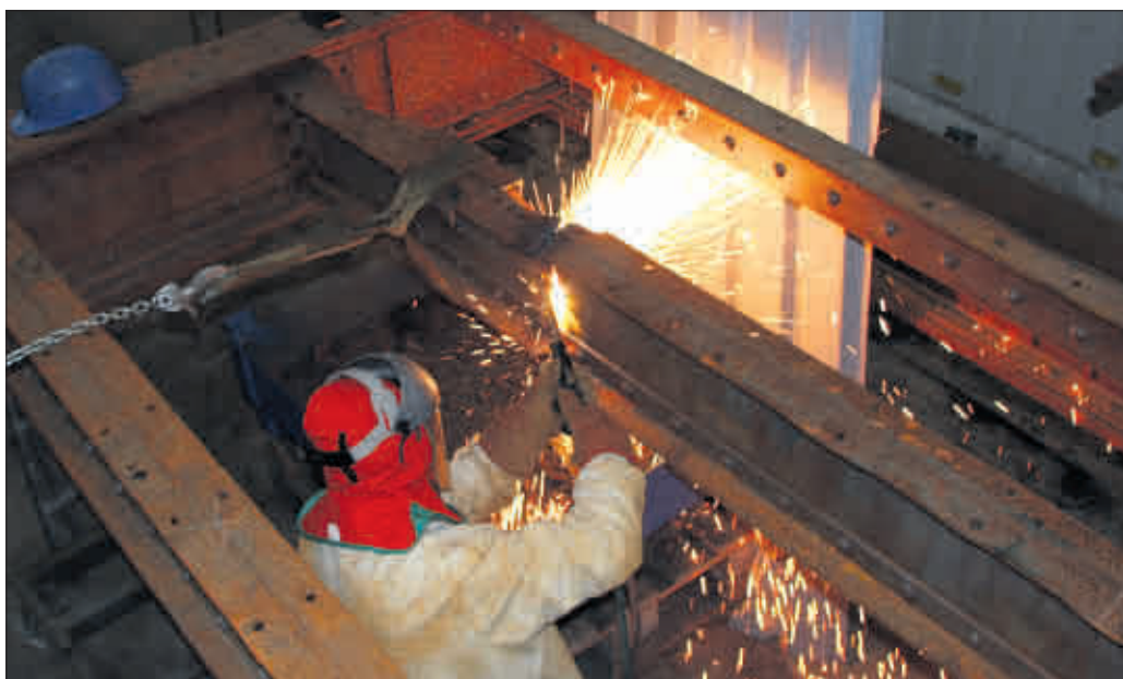
Mühsam: Um durchgerostete Teile auszutauschen, müssen Dutzende Nietten abgeflex, erhitzt und geöffnet werden.
