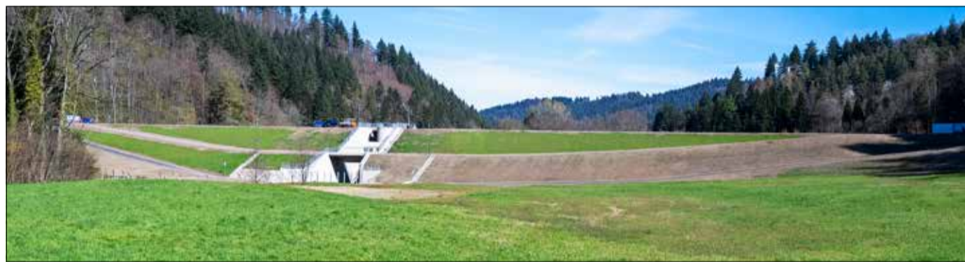
Schutz bei Starkregen: Bis zu 200 000 Kubikmeter Wasser kann der Bohrerdam im Fall eines Hochwassers speichern. Der Durchlass (siehe auch Foto rechts) würde dann geschlossen, das Wasser gestaut und kontrolliert abgelassen.
