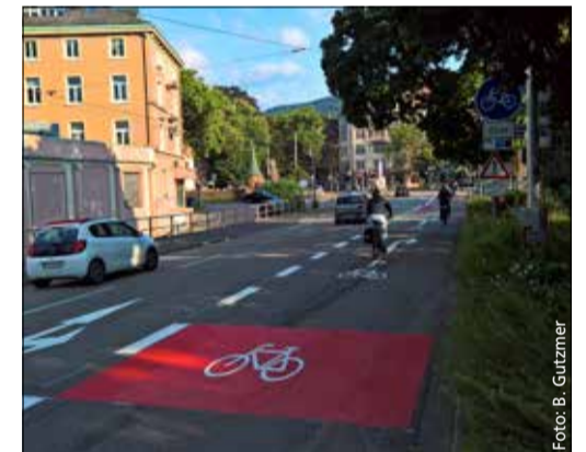
Nachher: Weniger Platz für Autos – dafür ein breiter, rot markierter Streifen, auf dem es sich sicher und komfortabel radeln lässt.
