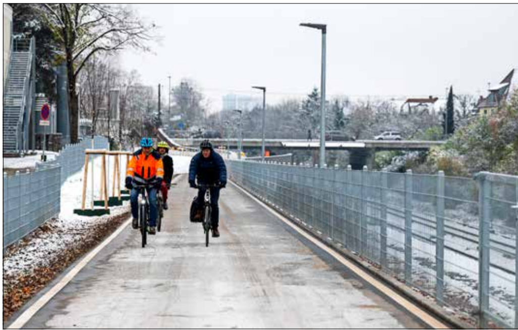
Endlich direkt an der Bahn entlang: Wer von St. Georgen kommend Richtung Güterbahndirekt radelt, muss künftig nicht mehr durchs Uniklinik-Gelände fahren. Der kürzlich bei klirrender Kälte eingeweihte Lückenschluss am FR2 ist ein wichtiger Teil der städtischen Fuß- und Radoffensive.
