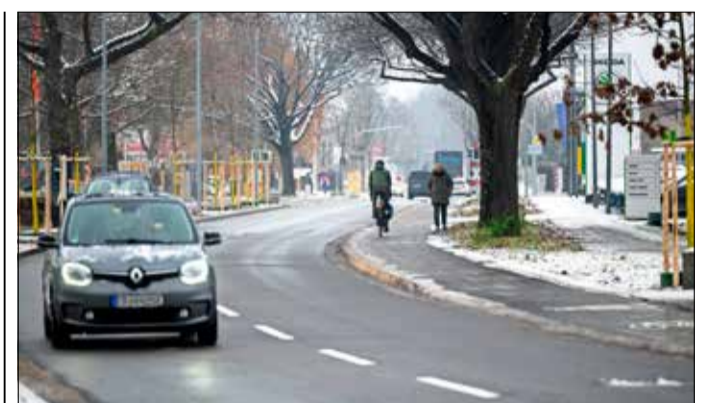
Alles frei, alles schön: Kaum war die Baustelle weg, nahm der Winter Besitz von der frischen Tullastraße.
