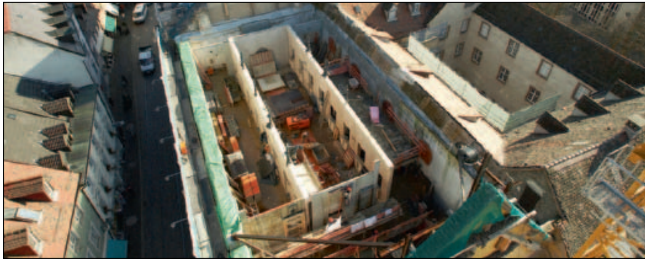
Museum ohne Dach: Im Sommer 2008 wurde der Dachstuhl komplett abgetragen, saniert und wieder aufgerichtet (F2)
