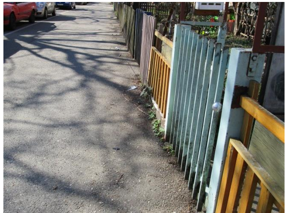
Bauhistorisch untypische Einfriedung
