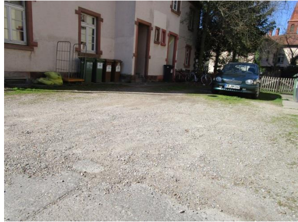
Unattraktive und nicht funktional gestaltete Gebäudevorzonen
