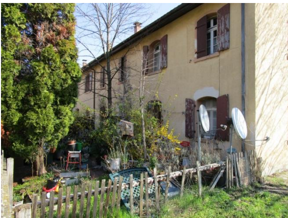
Defekter Zaun an einem Vorgarten
