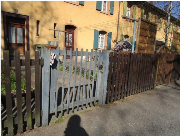
Bauhistorisch untypische Einfriedung
