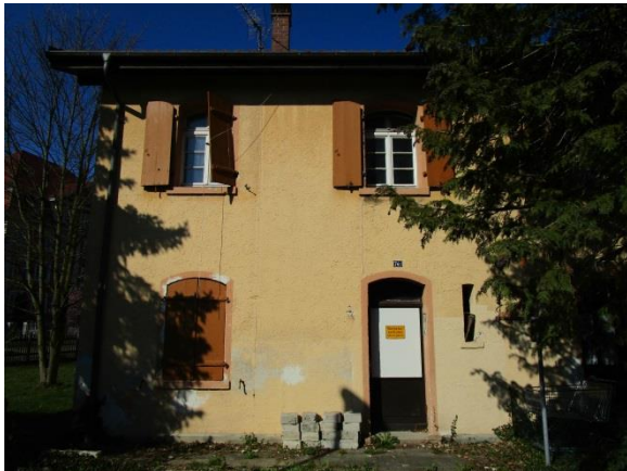
Wohnungsleerstand aufgrund baulicher Missstände
