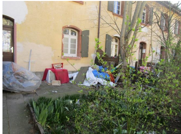
Fehlende gärtnerische Gestaltung und Flächen für Abfallbehälter
