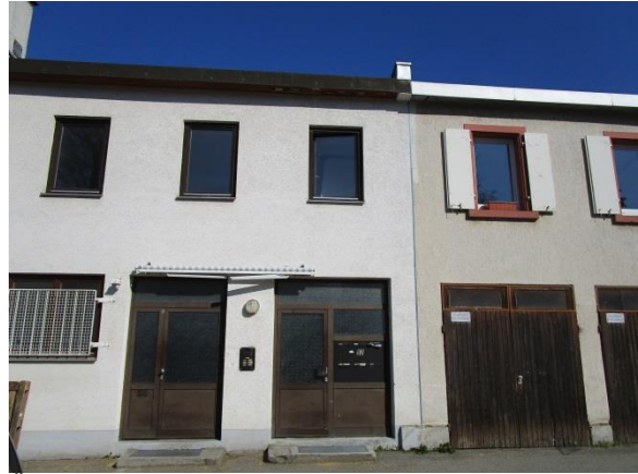
Überformung der Gebäudefassaden
