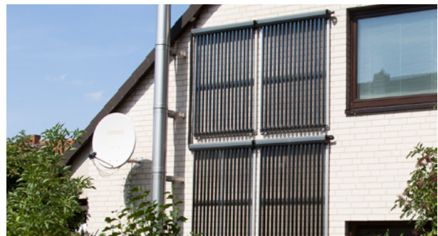
Röhrenkollektor, Quelle: ©Solvis GmbH
